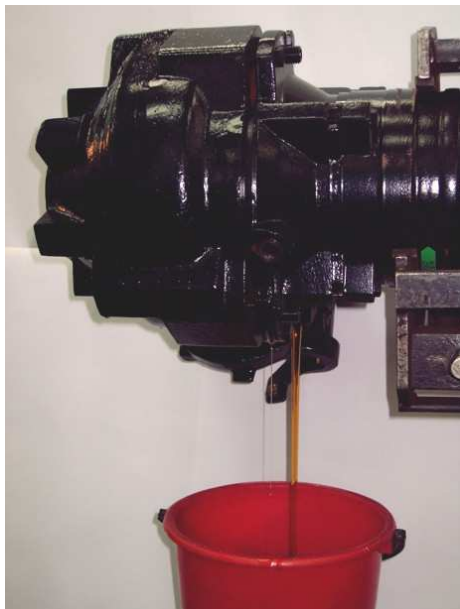
Opróżnianie komory olejowej
